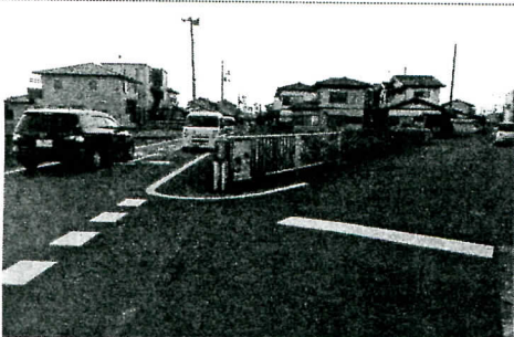
一時停止線、点線が標示された交差点
